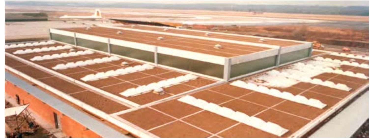
Project year: 1977 | Hangar di rimessaggio Aeroporto "La Malpensa", Malspensa (VA), Italy | Sarnafil® G 442-12
