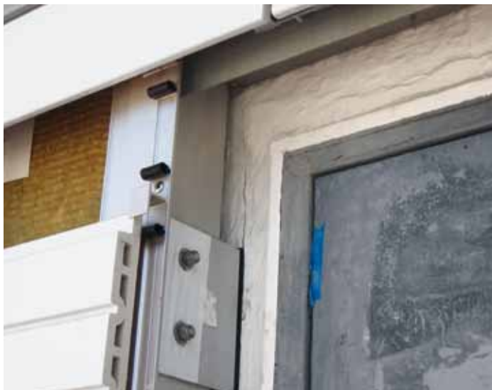
Sikagard®-560, eine wasserbasierte, dampfdurchlässige Flüssigfolie wurde als Wasser- und Luftbarriere eingesetzt, bevor die Isolation und das neue Vorhangsystem installiert wurden.
