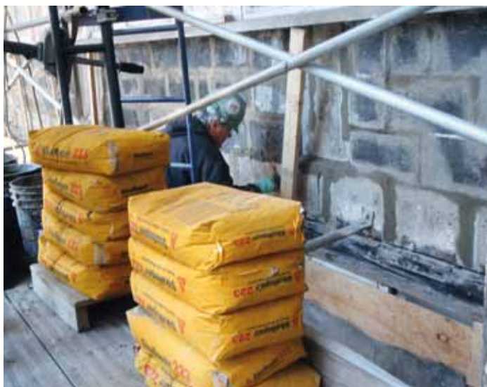
Der Reparaturmörtel SikaRepair®-223 wurde genutzt, um die Fugen, Risse und Spalten in den bestehenden Betonmauerstrukturen auszubessern und einen einheitlichen Untergrund zu schaffen.
